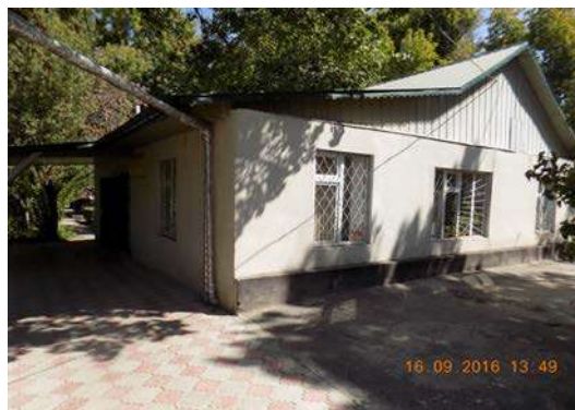
Здание отдела по исследованию вещдоков (после кап.ремонта 2013.г.)
